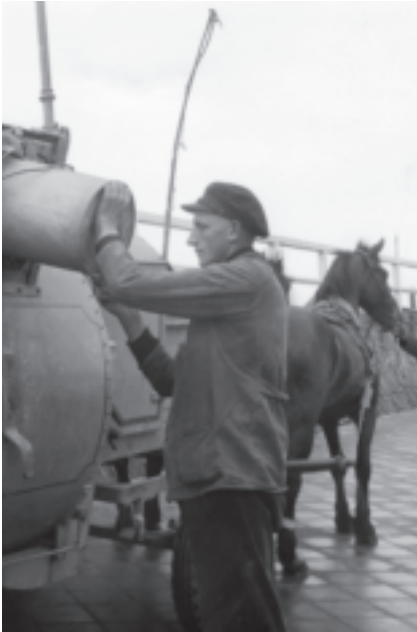
Bauer Pferdemüllwagen mit Ringsystem "Es-Em" für 35 l Ringeimer, Norderney 1936
